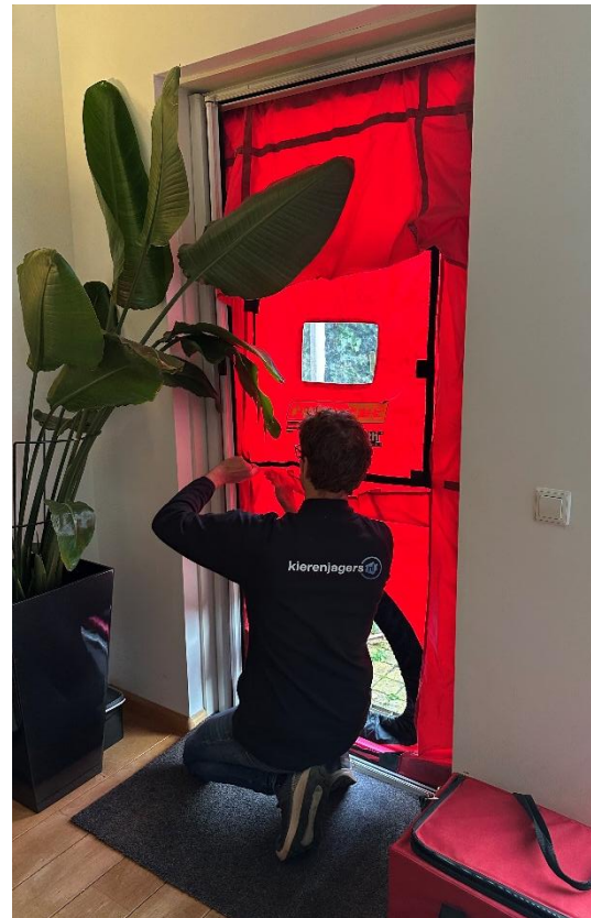
Afbeelding 1 Voor het vinden van de kieren is een grote ventilator gebruikt
