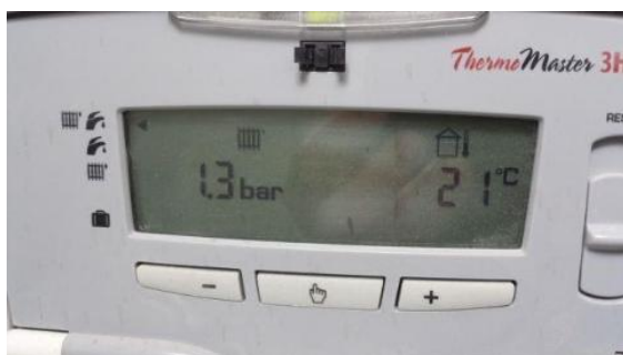
Afbeelding 16 Digitale waterdrukmeter. De waterdruk is 1.3 bar
