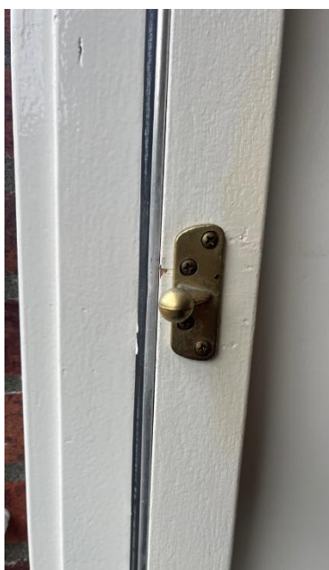
Afbeelding 3 Versleten inbouw tochtstrip in kozijn
