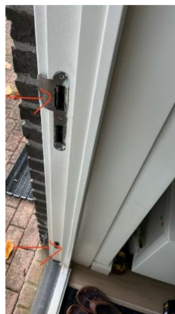
Afbeelding 4 Deurslot strakker afstellen
