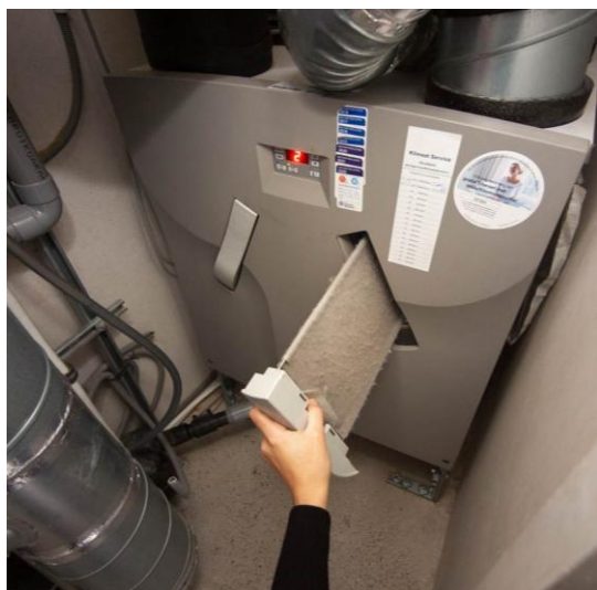
Balansventilatiesysteem
